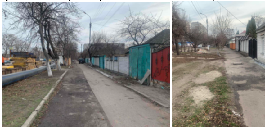
Рис 20. Дорога місцевого значення, яка проходить паралельно головному проспекту, які не були порушені будівництвом. Всі роботи проводилися в зеленій зоні між проспектом та дорогами (зліва на фотографії)
